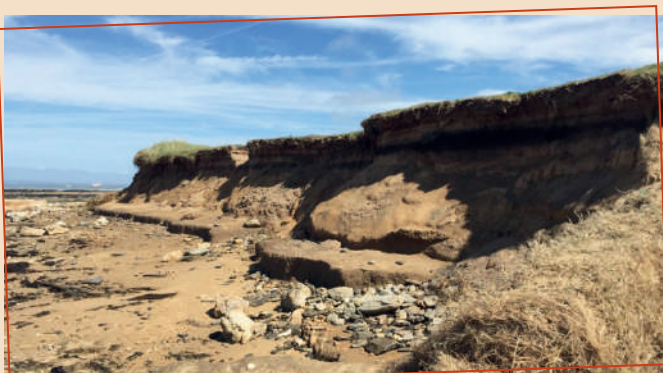
Erosion plage de l'Herbaudière
